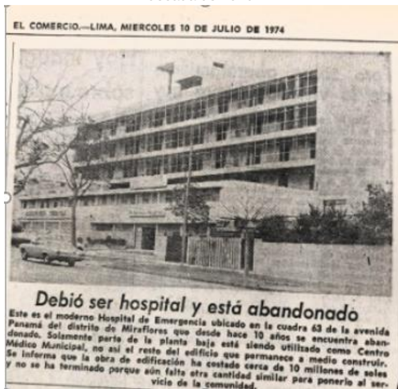
Figura 06. Edificio de la antigua Asistencia Pública de Miraflores, en la década de 1970.
